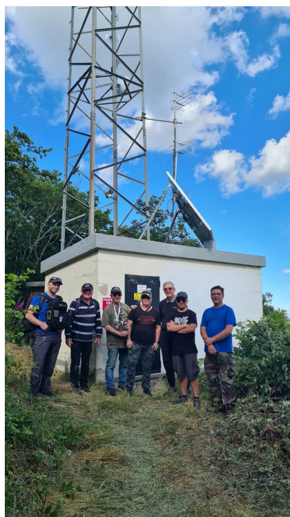
Vous avez bien travaillé les gars ! Les quads apparaissent derrière les panneaux solaires
