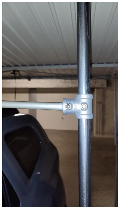
Le système de fixation des tubes
