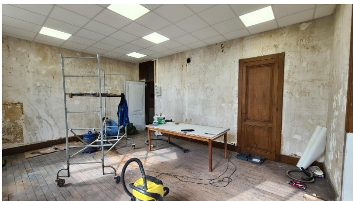
Nettoyage des murs, préparation et pose de toile de verre avant peinture
