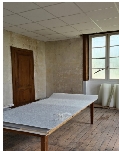
Nettoyage des murs, préparation et pose de toile de verre avant peinture
